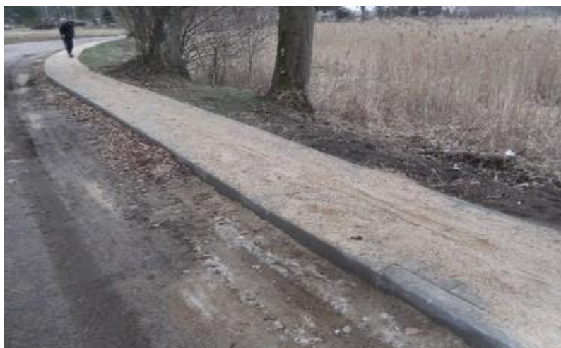
Budowa chodnika w miejscowości Mołdawin
