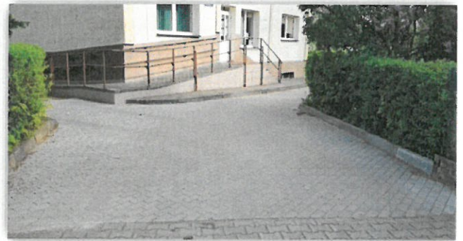
Ułożenie kostki polbrukowej przy Ośrodku Zdrowia w Radowie Małym
